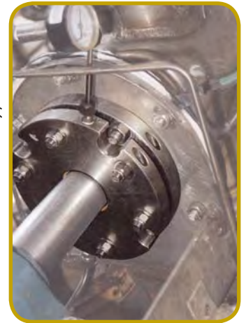
3" (75 mm)シャフトの付いた コンペアのEA TYPE-2Sシール
